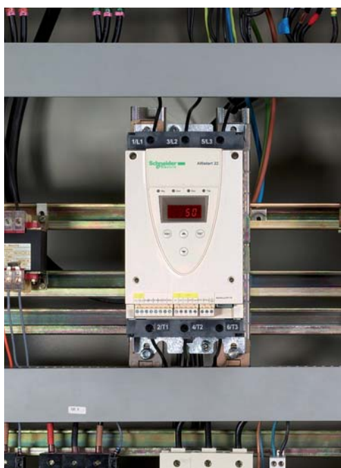
(1) Шунтирование устройства плавного пуска.
